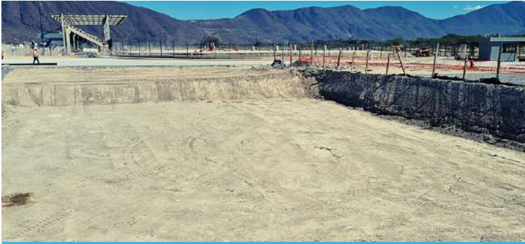
Trabajos preliminares: excavación del vaso y afine de las superficies.
