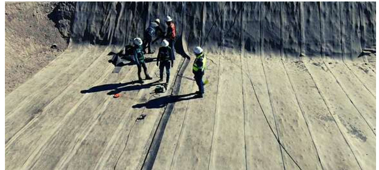
Preparación y limpieza de las superficies de contacto para traslapes de Concrete Canvas™.
