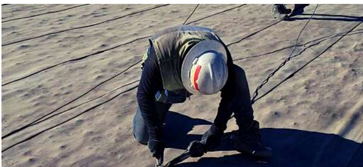
Unión por termobonding procurando traslapes de al menos 10 cm., en todas direcciones.
