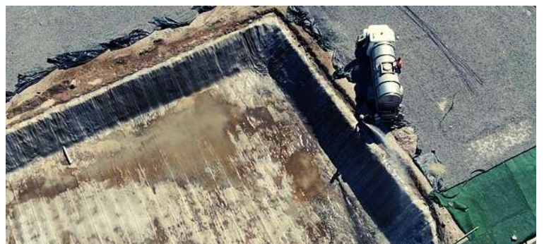
Hidratación del CC5 por medio de aspersión sin presión con la ayuda de una pipa. Este proceso se repitió un par de veces más después de la primera hidratación.
