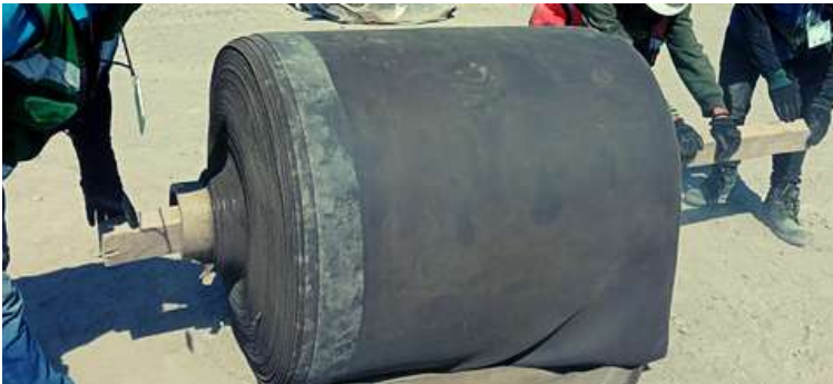
Tendido y alineación de los lienzos, desenrollando el CC5 de lado a lado del vaso regulador, en el sentido más corto del vaso regulador y anclado sobre los taludes laterales.
