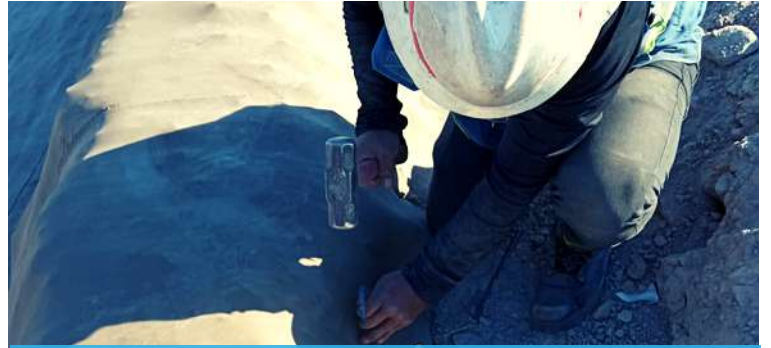
Fijación de los extremos de lienzos de CC5 en trincheras perimetrales de anclaje de 30 x 30 cm
