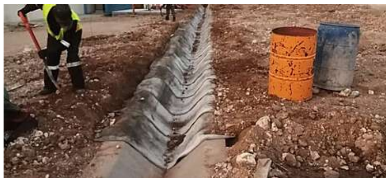
5. Se rellenaron las trincheras de anclaje nuevamente con el mismo material producto de su excavación.
