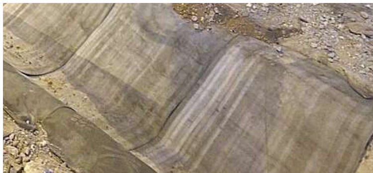
2. Sujeción de los extremos de los lienzos de CC con estacas de varilla corrugada de 3/8" procurando traslapes de 10 cm.
