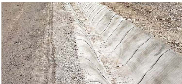
6. Se detalló con mortero las uniones con los registros y demás elementos de concrete existentes.
