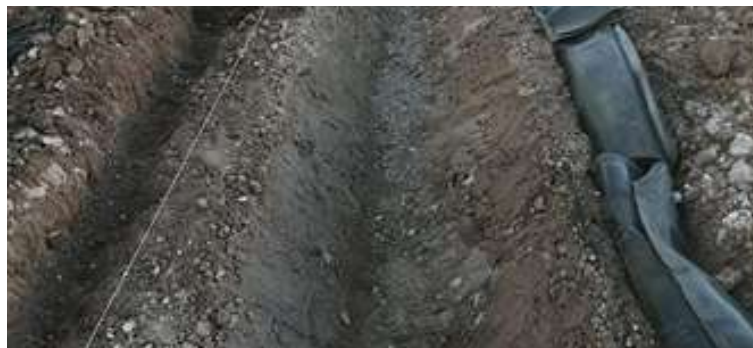
1. Excavación de las trincheras de anclaje a los lados de las cunetas excavadas previamente.
