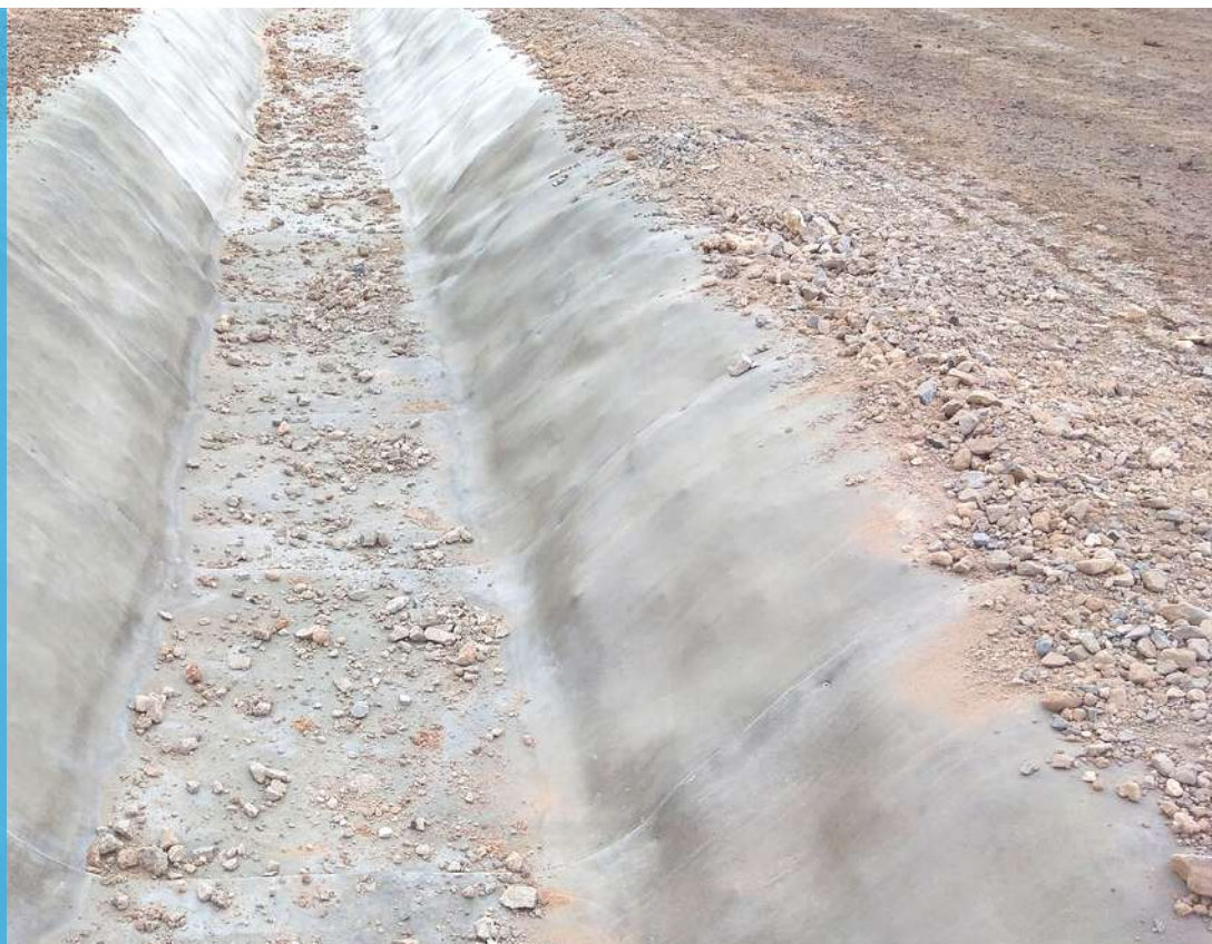
Recubrimiento de drenaje superficial con Concrete Canvas™ CC5, Ciudad Juárez, Chihuahua, Mex.
