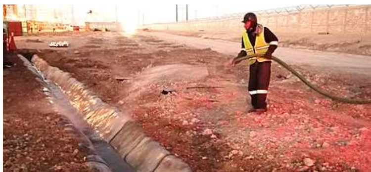
4. Se hidrató por medio de riego con pipa, en al menos dos ocasiones, todos los tramos.
